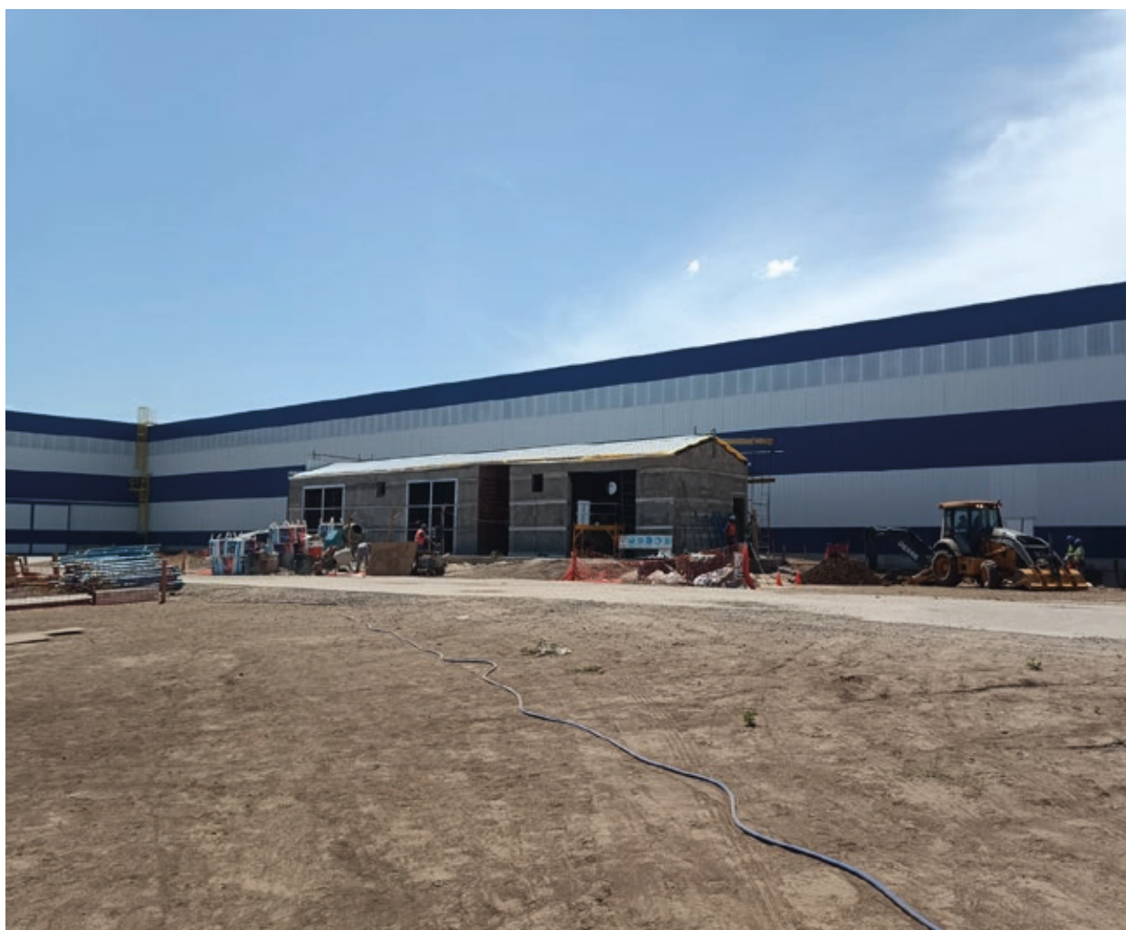
SUB ESTACIÓN TRANSFORMADORA SIDERSA S.A Ejecución llave en mano de Nave y SET.
